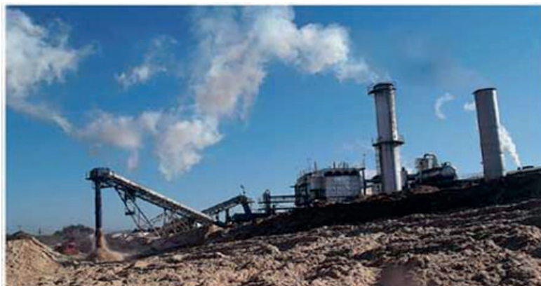
Figura 6 - Bagaço de cana sendo queimado em caldeiras
