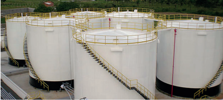
Figura 10 - Tanques de armazenamento de etanol
